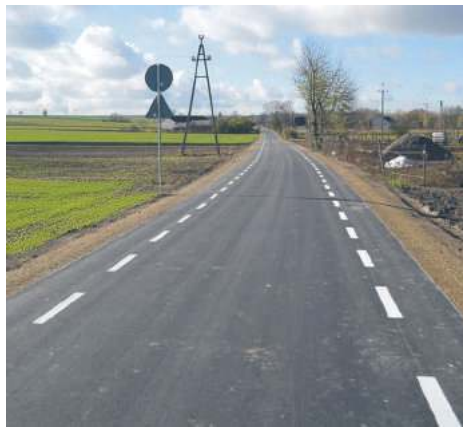
Przebudowa 23 odcinków dróg o długości ponad 21 km
