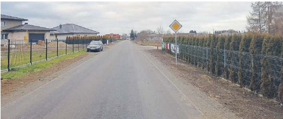
Rozbudowa drogi gminnej - ul. Ziołowa w Susznie
