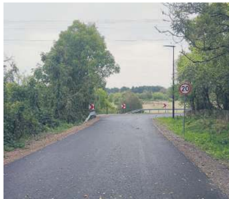
Rozbudowa drogi gminnej w Stawkach
