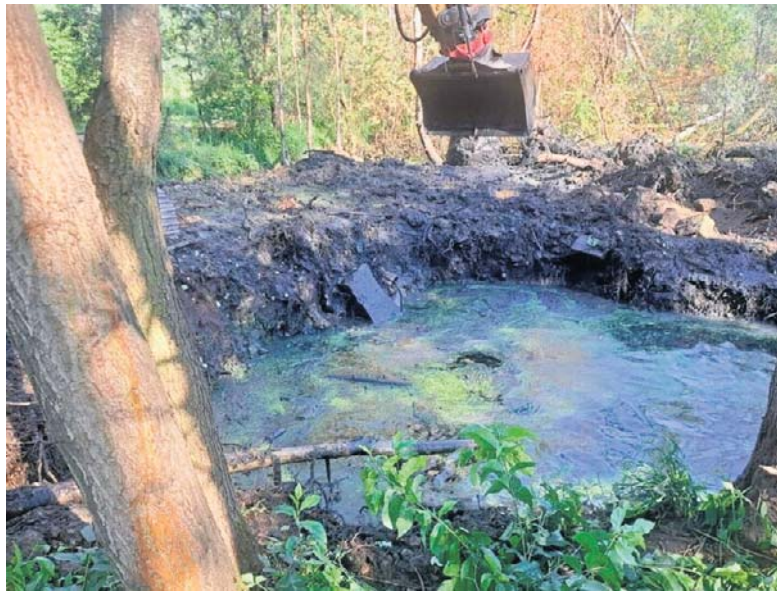
Plukon na własny koszt usuwa pozostałości zanieczyszczeń
