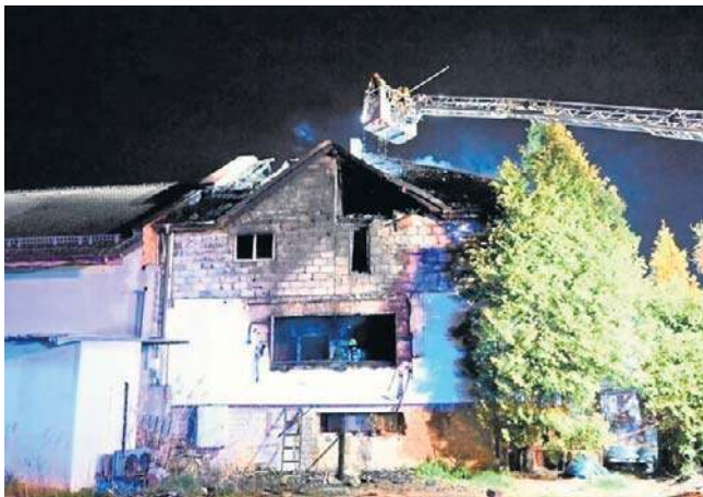
Pożar budynku w Pszowie miał tragiczny finał. Zginęło pięć osób
