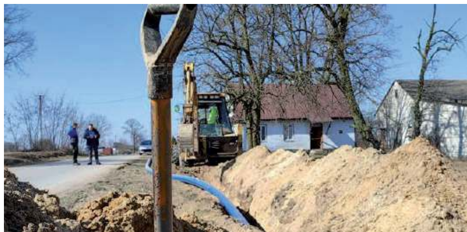
Prace ziemne podczas przebudowy odcinka sieci wodociągowej w Łuniewie
