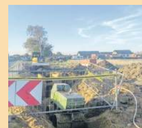
W Ludowie Śl. trwają prace związane z rozbudową sieci kanalizacyjnej i wodociągowej. Fot. UG Borów
