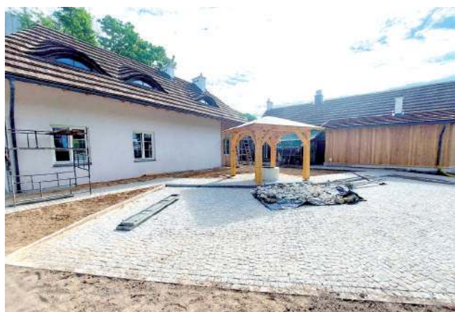
Wygląda na to, że świetlica środowiskowa w Kazimierzu Dolnym zmierza ku końcowi prac. W ciągu kilku dni zostanie oficjalnie odebrany budynek. Otwarcie zaplanowano dopiero za kilka miesięcy
