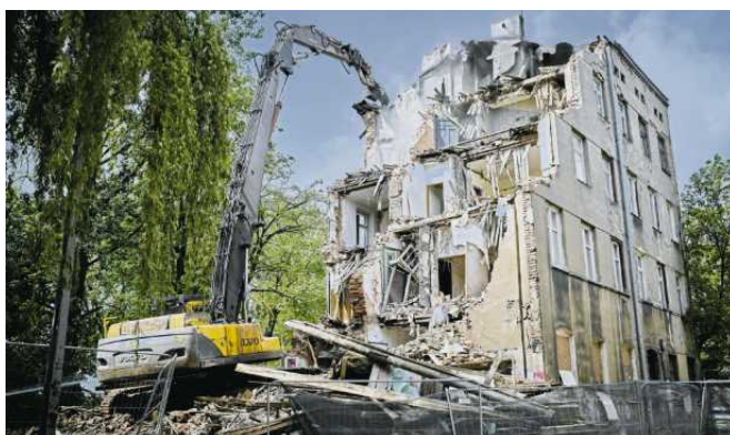
• Rozbiórka kamienicy przy ul. Franciszkańskiej
