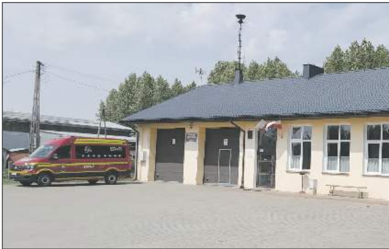
■ Budynek jest budynkiem historycznym. Wybudowany został w latach 1975-1978. Oprócz ocieplenia przewiduje się również roboty budowlane zmierzające poprawy dostępności komunikacyjnej dla osób z niepełnosprawnościami
