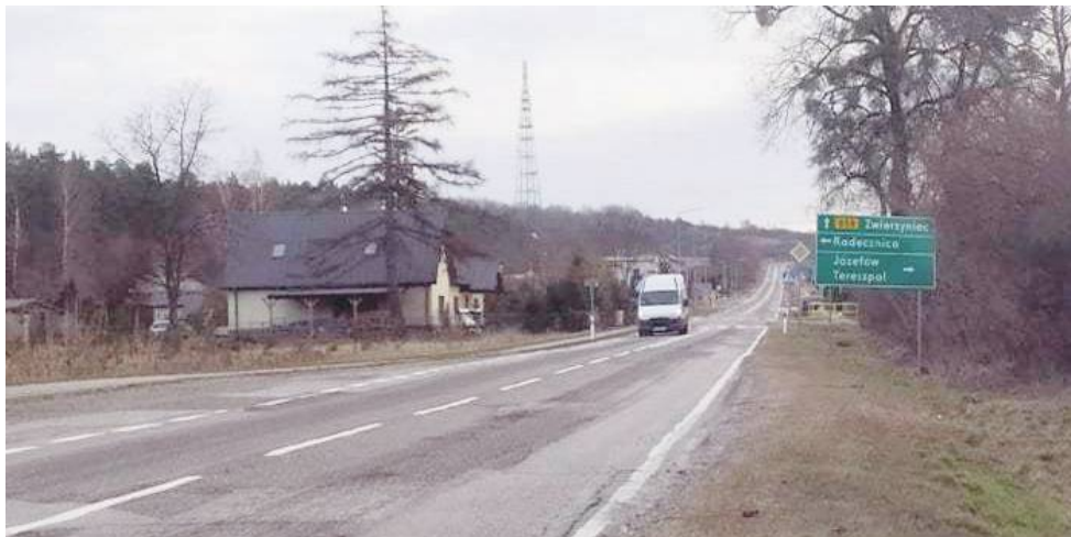
Na drodze wojewódzkiej 858 na kierowców czekają liczne ubytki i nierówności.
