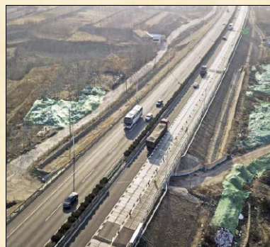
9. Odcinek chińskiej drogi z paneli fotowoltaicznych
