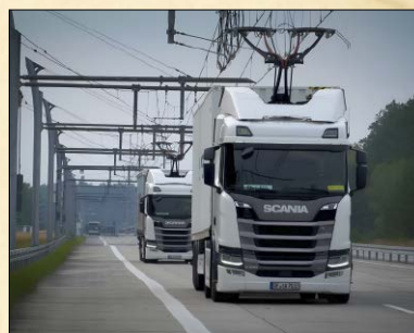
10. Trakcja eHighway na niemieckiej autostradzie
