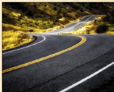
2. Droga w USA o nawierzchni z tarmacadamu
