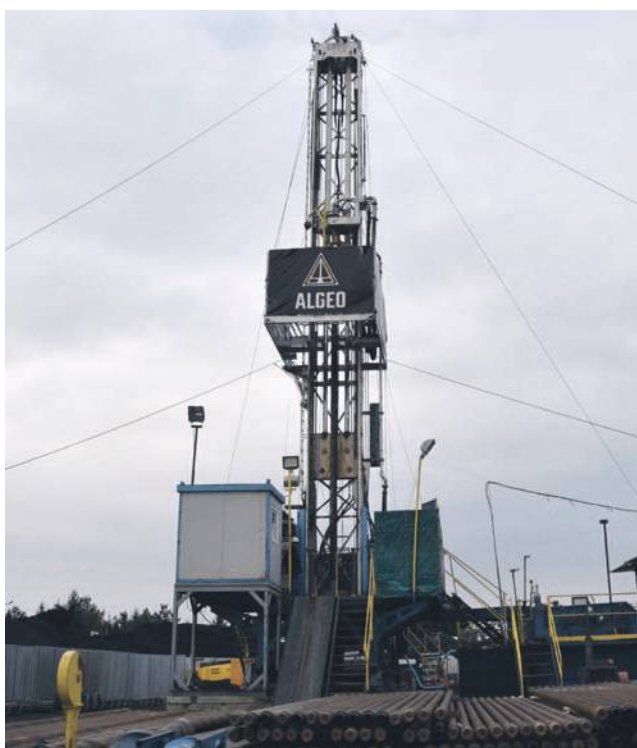
W listopadzie 2022 roku rozpoczęły się prace wiertnicze
