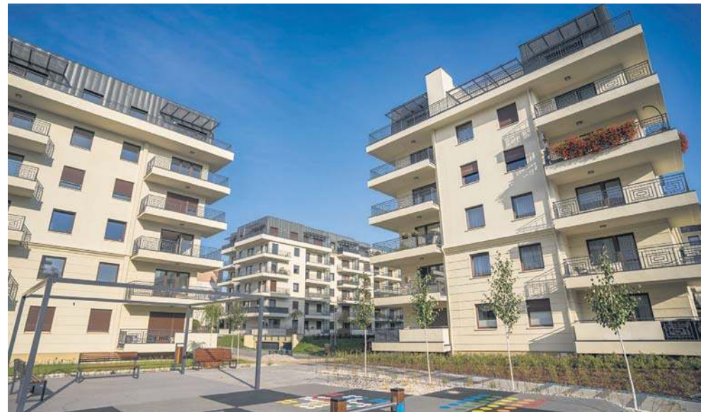
Jedną z budzących zachwyt inwestycji, w których P.W. „Lech” było generalnym wykonawcą, jest Osiedle Paryskie.
