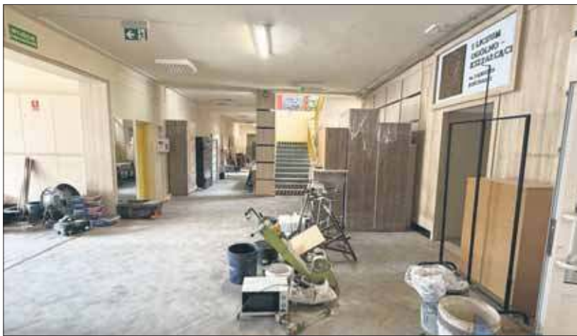
Remont I Liceum Ogólnokształcącego w Jaworznie
