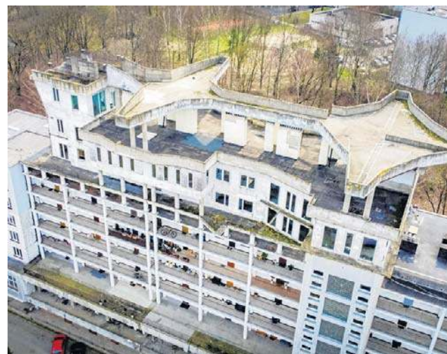
Część nadbudowy została już rozebrana
