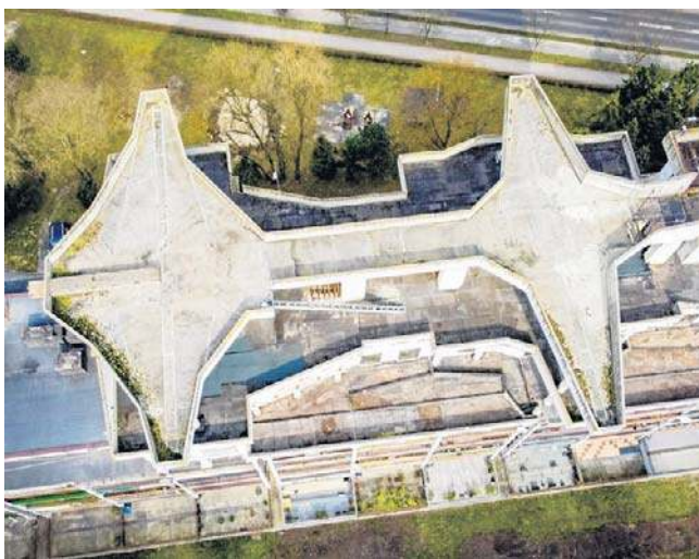
Lądowisko miało służyć do obsługi balonów
