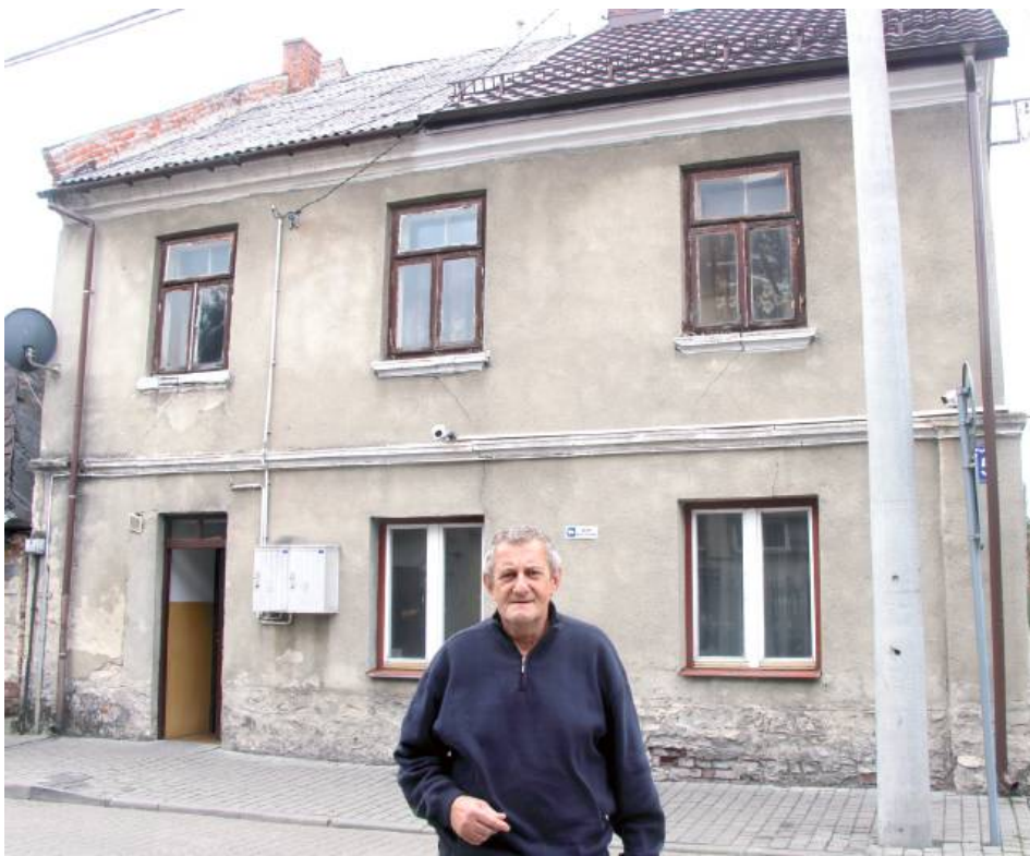
Bogdan Szymczak, współwłaściciel kamienicy, w której od lat mieszka niechciany lokator
