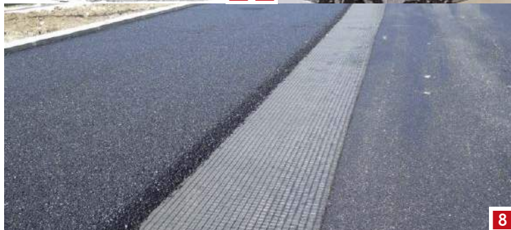
6. Układanie asfaltu na drodze w XIX w.; 7. Rodzaj mieszanki betonowo-asfaltowej; 8. Współczesna warstwa geowłókninowa; 9. Jeden z typów geokrat nawierzchniowych
