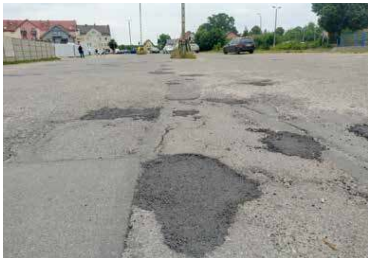
Prace polegające na łataniu dziur na łączniku przeprowadzono ponad tydzień temu
