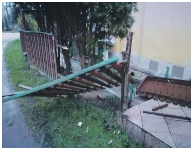
Oskarżony nie przyznał się do celowej dewastacji ogrodzenia. Powiedział, że płot mógł zniszczyć opierając się o niego podczas rozmowy
