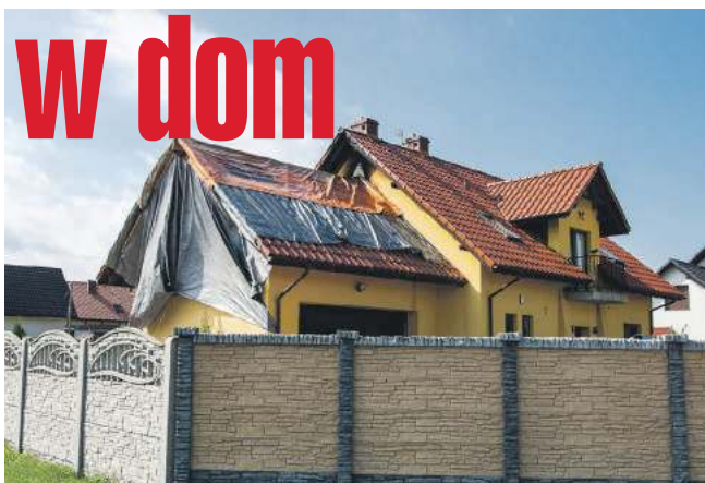
Dach został tymczasowo zabezpieczony plandekami
