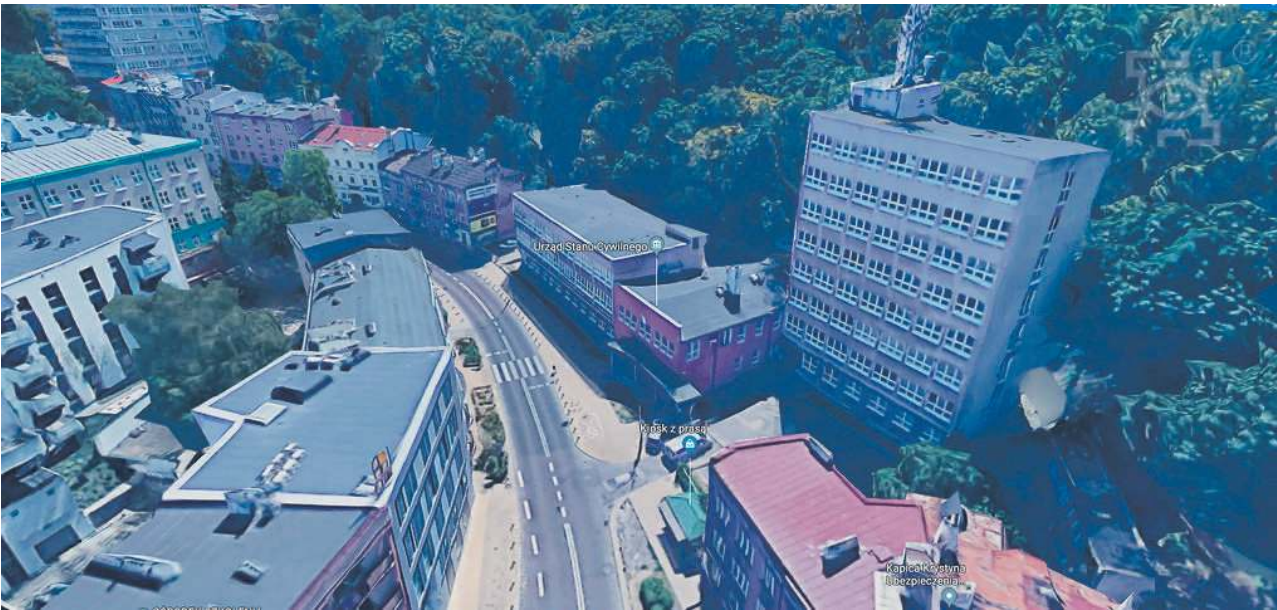
Stary budynek Urzędu Miasta przy ul. Leszczyńskiego zniknie z powierzchni ziemi, a w jego miejsce powstanie nowoczesny biurowiec ze szkła i aluminium
