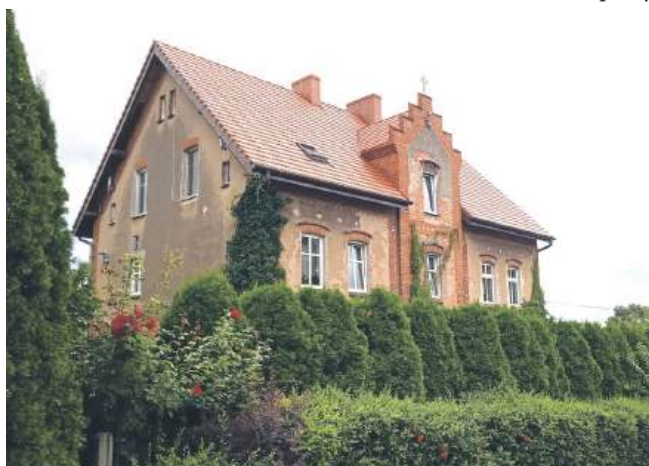
Budynek dawnej szkoły.
