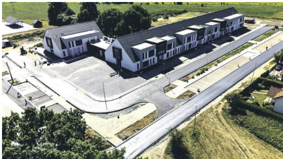
Prace przy zagospodarowaniu przy szkole dobiegły końca
