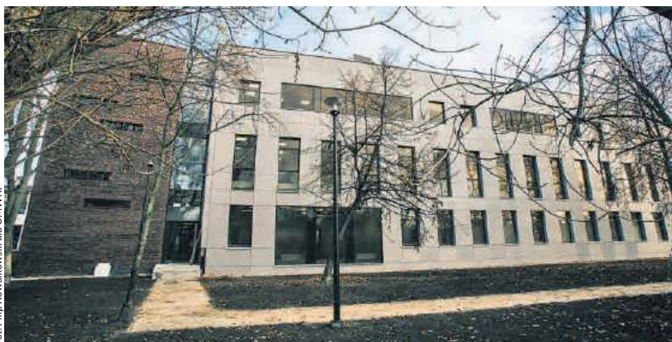
Powierzchnia trzykondygnacyjnego obiektu przy ulicy Staffa w Bydgoszczy wynosi ponad 17, tys. metrów kwadratowych
