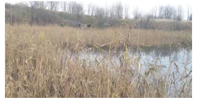
Staw, który ma być czyszczony, obecnie jest w znacznym stopniu zarośnięty i zamulony. Fot. Stowarzyszenie „Nasza Woda”
