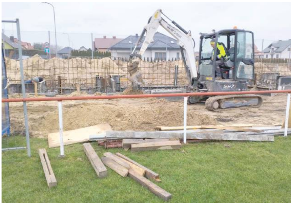
Przy boisku w Księżpolu powstają nowe trybuny dla publiczności. Przy szkole rozpocznie się także budowa nowego boiska ze sztuczną nawierzchnią
