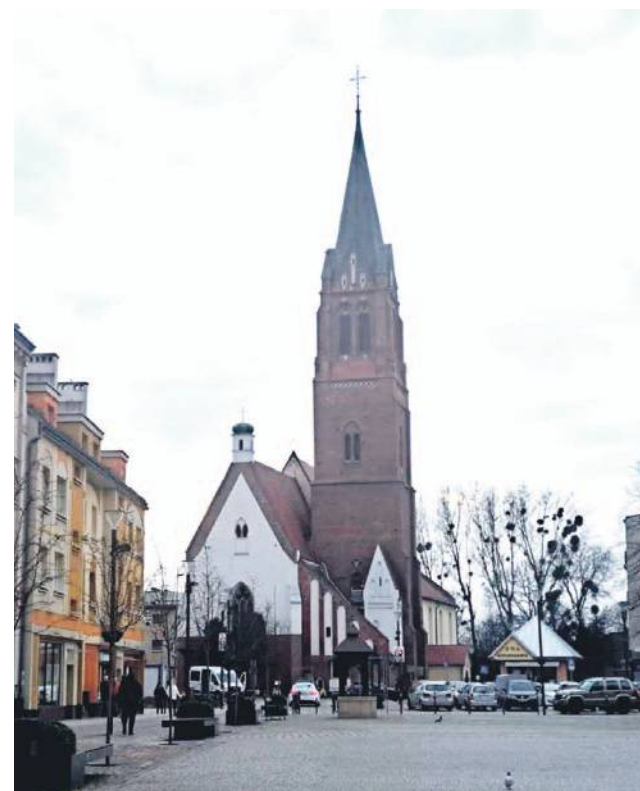
245 tys. zł dotacji przyznano na wykonanie dokumentacji architektoniczno-budowlanej i konserwatorskiej dotyczącej remontu kościoła pw. NMP Matki Pocieszenia w Oławie
