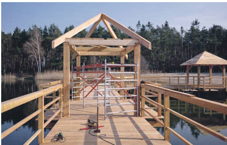
Widać już finał budowy pomostu rekreacyjnego na stawie w Jelczu-Laskowicach
