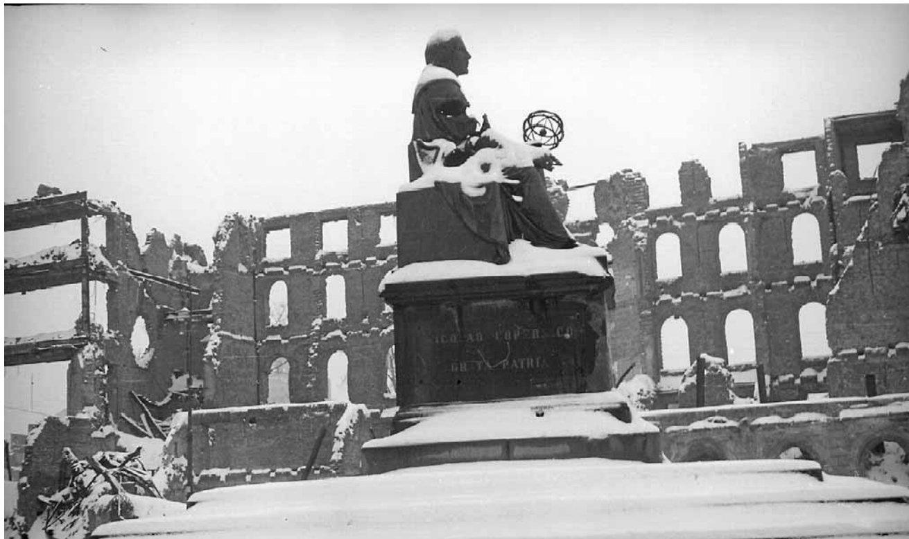
Warszawa, pomnik Kopernika na tle zburzonych budynków przy Nowym Świecie
