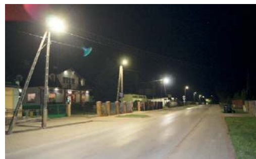
Zmodernizowane oświetlenie uliczne
