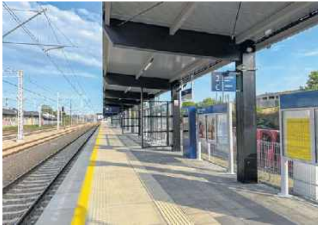
Prace objęły m.in. przebudowę pięciu torów, sieci trakcyjnej oraz modernizację urządzeń telekomunikacyjnych
