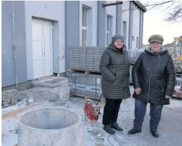
Sołtys Bogusław Cymbaluk (z prawej) oraz Stanisław Drozd – członek Rady Sołeckiej przed remontowaną świetlicą wiejską w Wyszonowicach
