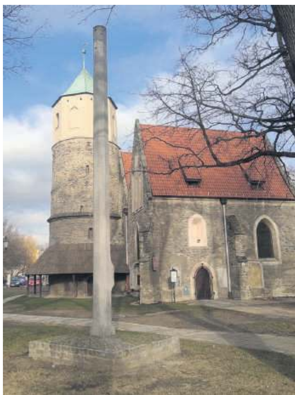
Granitowe „coś” stoi w bezpośrednim otoczeniu Rotundy św. Gotarda
