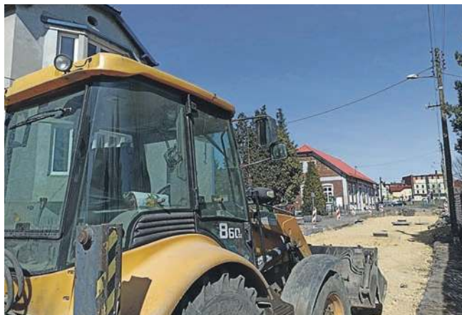
Ulica Ochronkowa rozkopana - trwają roboty drogowe
