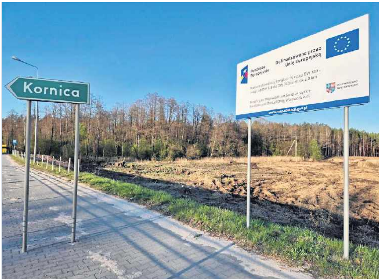
Zachodni kraniec przyszłej obwodnicy. Trwa wycinanie drzew i krzewów pod nową drogę.
