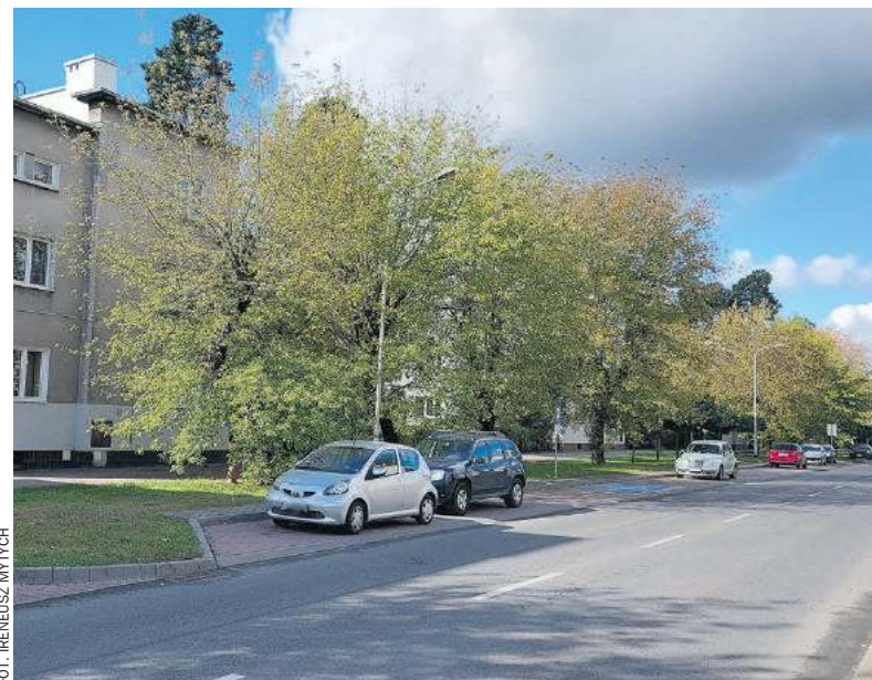
Przebudowa miejsc parkingowych równoległych na skośne okazała się niemożliwa
