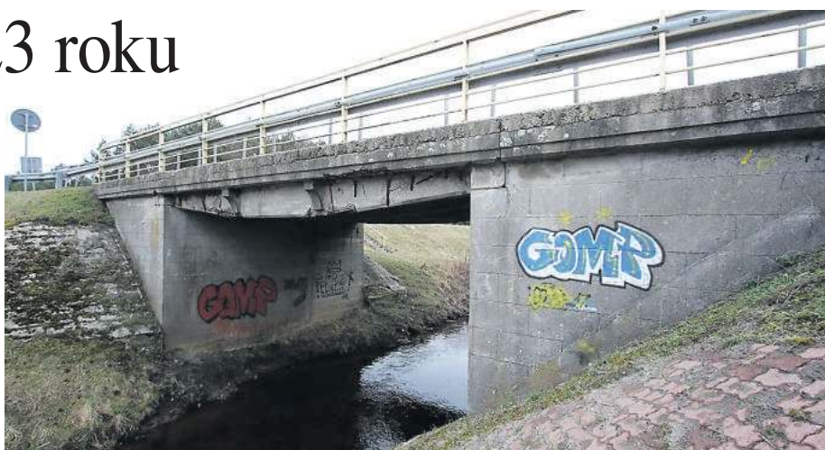
PZDW planuje rozbiórkę starego mostu i budowę nowego
