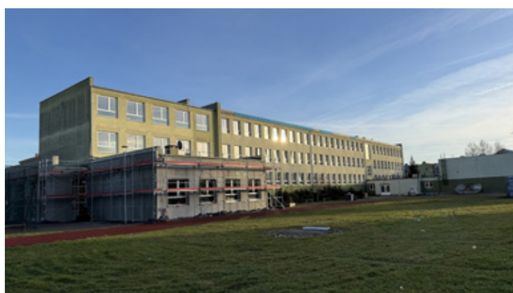
Jednym z najrozsądniejszych projektów była poprawa efektywności energetycznej Szkoły Podstawowej nr 5 oraz Szkoły Podstawowej nr 6. Prace o łącznej wartości 11 056 224,07 zł objęły wymianę stolarki okiennej, docieplenie ścian oraz modernizację oświetlenia i instalacji c.o. Na realizację tego zadania gmina pozyskała dofinansowanie zewnętrzne w wysokości 9 014 717,12 zł.
