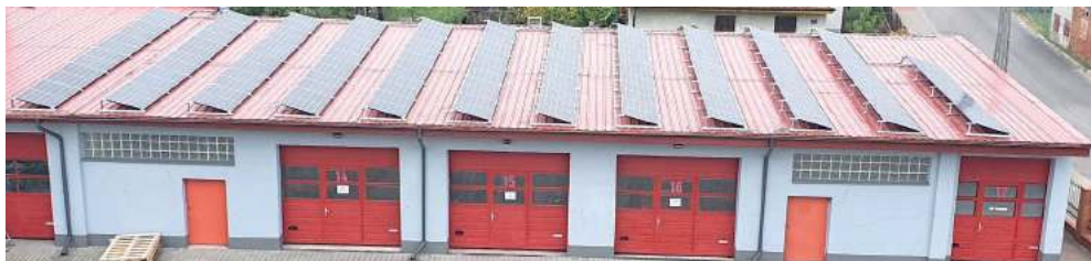
Zamontowana instalacja nie pokryje w 100 procentach zapotrzebowania parczewskiej komendy na prąd, ale przyczyni się zmniejszenia wydatków
