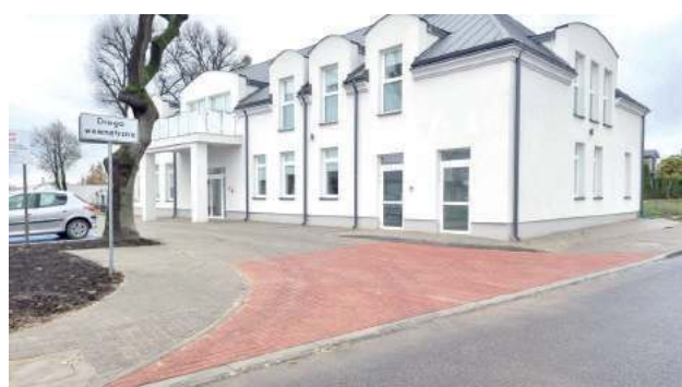
Przebudowę dwóch zjazdów i budowę parkingów SPZOZ finansował z własnych środków, a jego koszt to ponad 614 tys. zł
