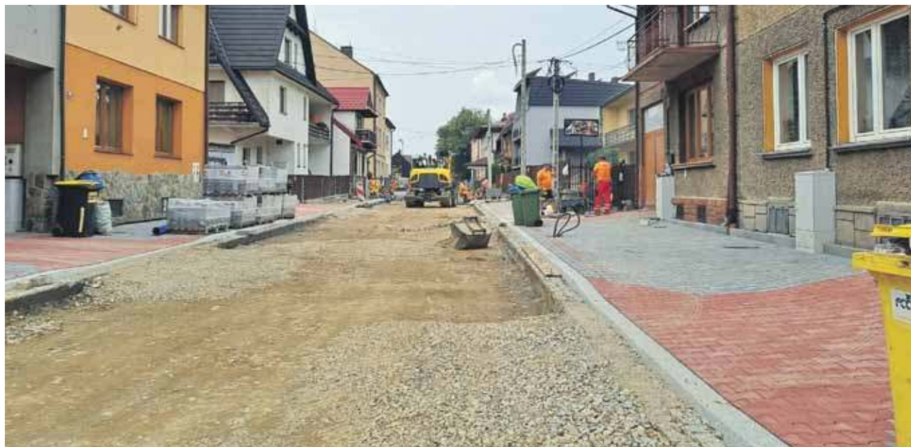
Ulica Nadwodnia już częściowo odzyskała chodniki.
