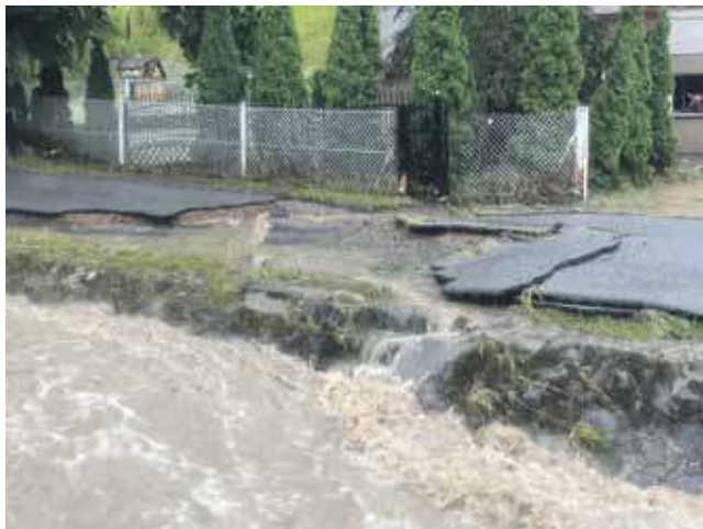
Ulewa, która przeszła nad miastem, doprowadziła do wielu zniszczeń.
