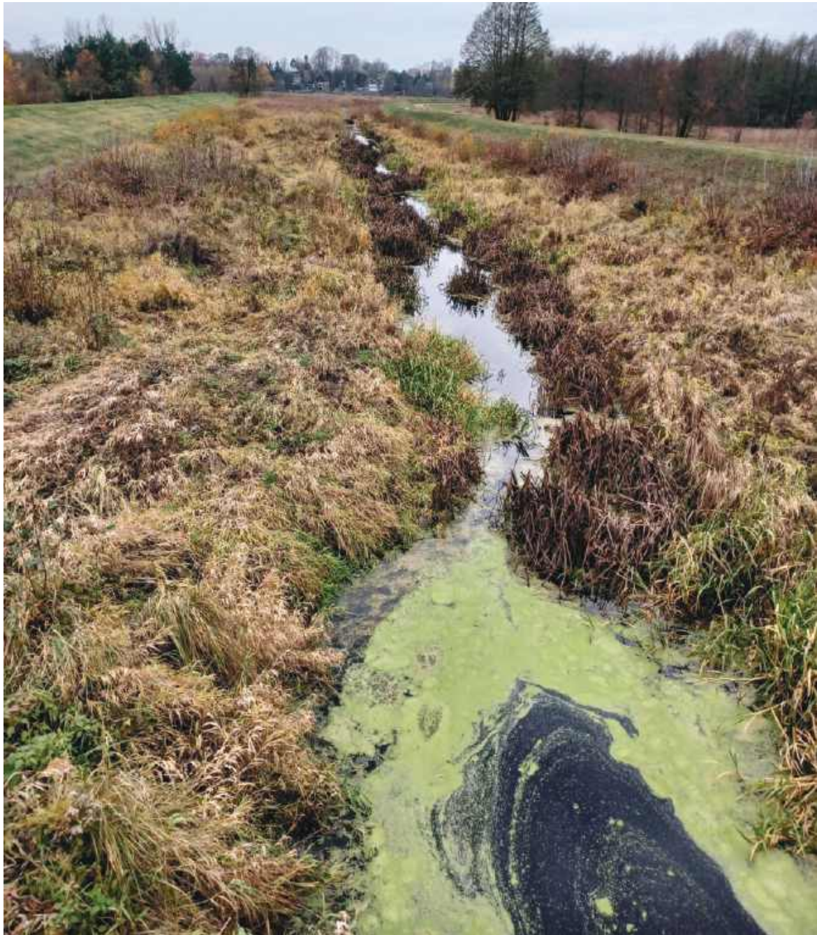
Prut przed rewitalizacją
