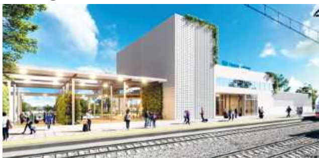
Nowy budynek od strony torów. Wizualizacja PKP S.A.
