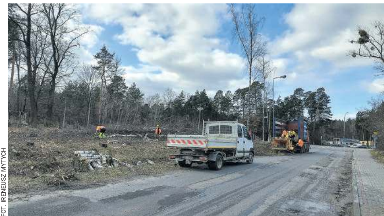
Ruszyły pierwsze prace przy ulicy Spacerowej
