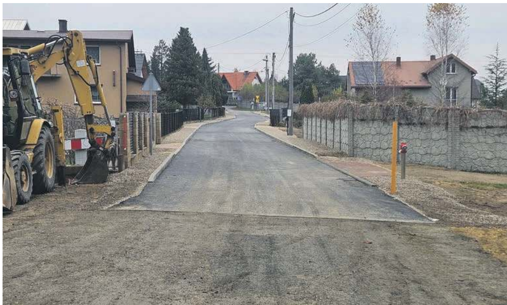
Ulica Robotnicza w Sierszy po zakończeniu prac
