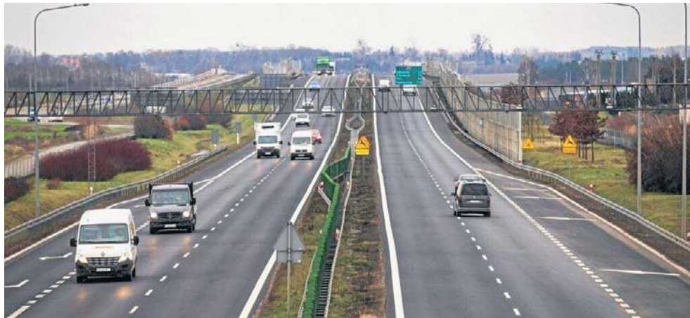
To gotowy fragment S11, audowa pierwszego śląskiego odcinka trasy S11 coraz bliżej
