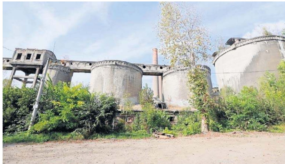
Cementownia Grodziec zmienia się właśnie w centrum kultury i wypoczynku
