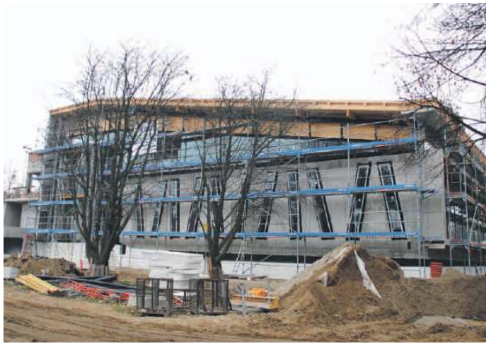
Termy Jakuba w budowie
