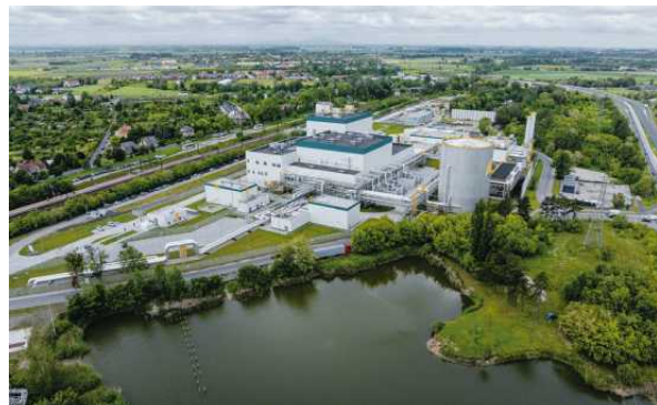
Elektrociepłownia gazowa Czechnica-2 w Siechnicach
