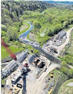
Prace przy budowie mostu kolejowego nad Mszanką
