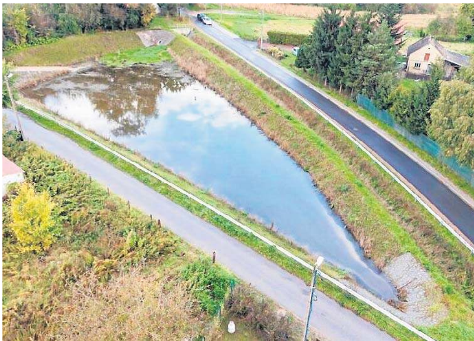
Nowy zbiornik retencyjny przy ul. Burzowej w Krakowie
