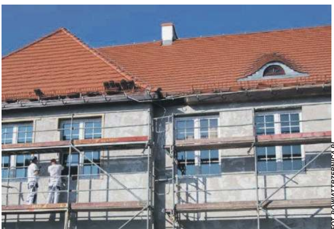
Prace przy ocieplaniu budynku szkoły
