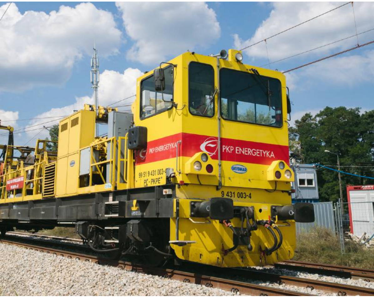
Na Mazowszu trwa odbudowywanie połączeń kolejowych | fot. Tomasz Jędrzejowski/Gazeta Polska
