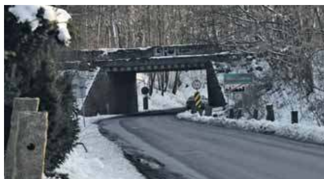
Wyburzenie tego wiaduktu sprawiło, że na drodze powiatowej Zbrostawice – Wieszowa pojawił się wzmożony ruch samochodów ciężarowych
