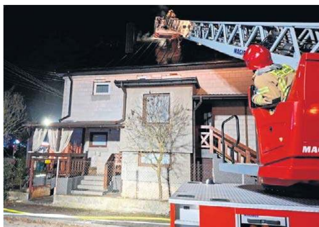
Pożar dachu domu w Morawicy. Jedna osoba trafiła do szpitala
