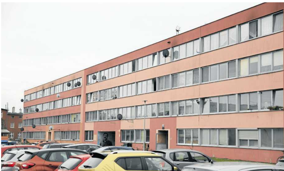
• Blok komunalny przy ulicy Ubocze 24 w Gdańsku
