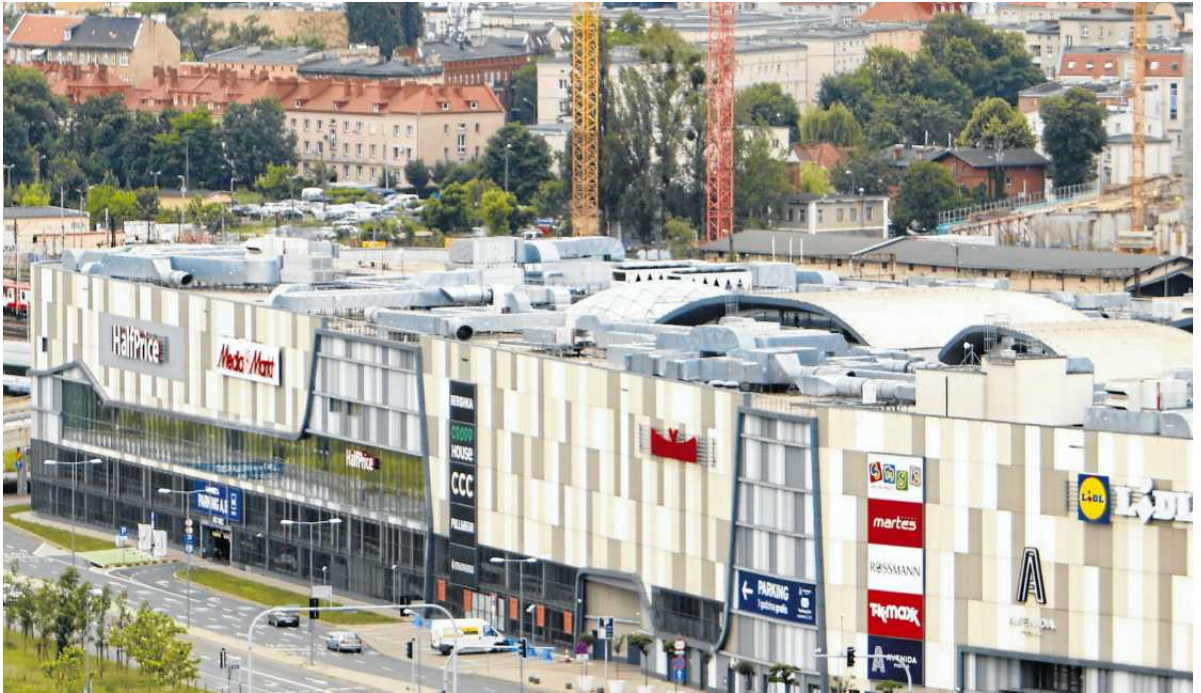
• Galeria Avenida Poznań Główny. W sklepie H&M runął fragment sufitu FOT. PIOTR SKÓRNIKI / AGENCJA WYBORCZA.PL
