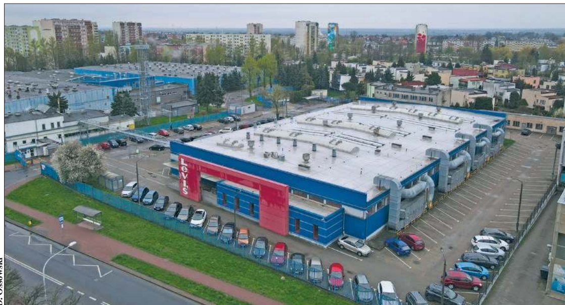
Zainteresowanie wydzierżawieniem części terenu po dawnej fabryce Levi'sa wyraziła firma ze Zgierza
